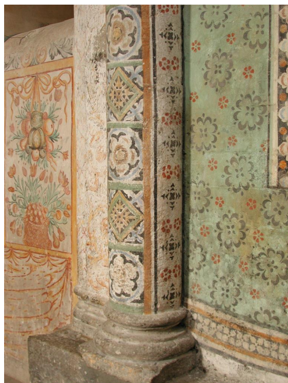
Valère : détail d'une colonne
