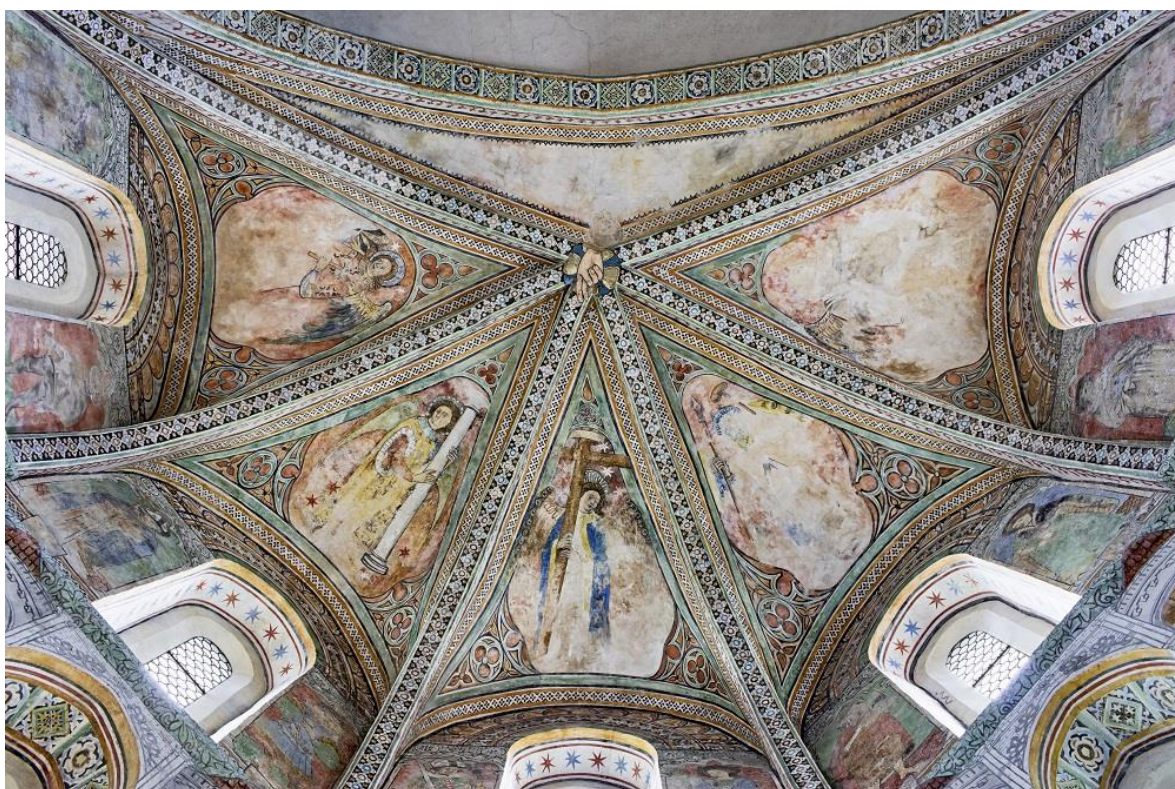
Basilique de Valère – Voûte du chœur
